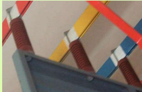
Şekil. Bara mesnet izolatörleri.
