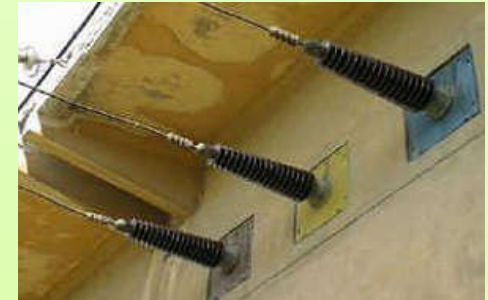
Şekil. Geçit izolatörleri.
